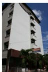
アパートの外観
